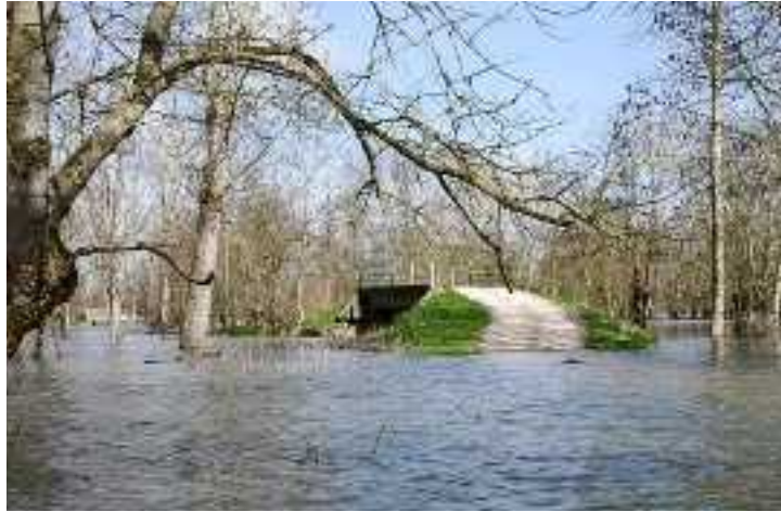
La dernière crue importante sur le Marais date de janvier 2006.
